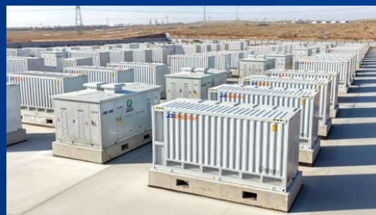
宁夏瀚骏150MW/600MWh储能项目 ——奇点能源组串式预制舱于宁夏成功应用
