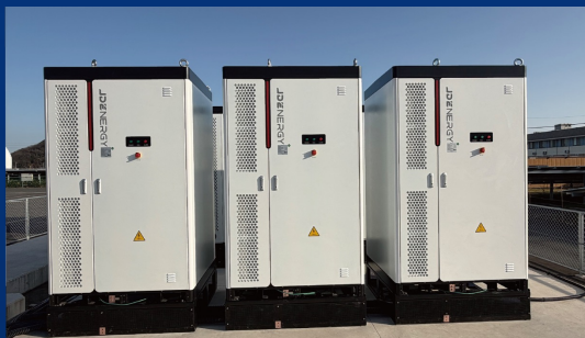
日本1.29MW/2.508 MWh用户侧储能项目 ——日本首个工商业储能项目、优化负荷、降本减碳
