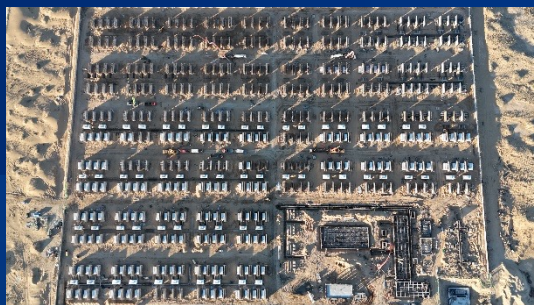
内蒙古磴口 500MW/2000MWh 储能电站 ——奇点能源首个GWh级储能项目
