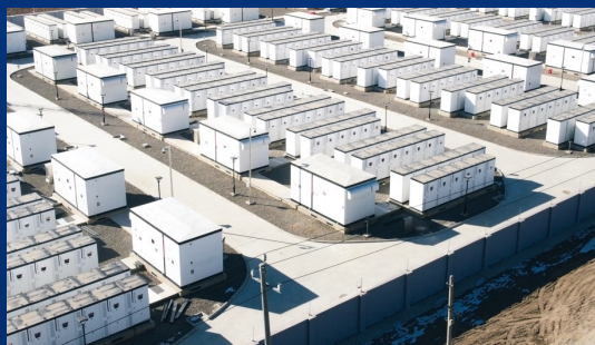
宁夏牛首山200MW/400MWh储能电站 ——全球最大的电网侧分布式模块化储能电站项目
