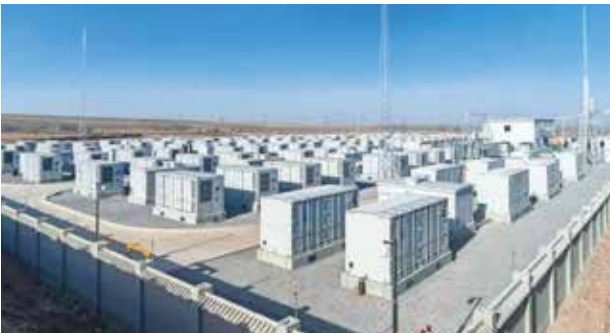
宁夏瀚骏150MW/600MWh储能项目 ——奇点能源组串式预制舱于宁夏成功应用
