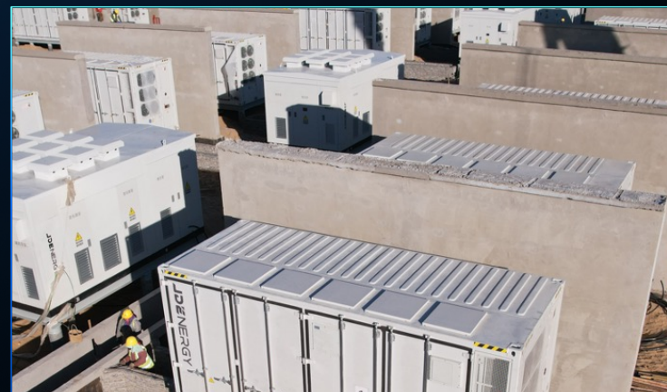
宁夏盐池150MW/600MWh储能电站项目 ——为宁夏新能源转型注入强劲绿色动能
